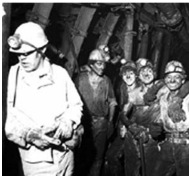
Unter Tage / Dans la mine Oberhausen, 1985
